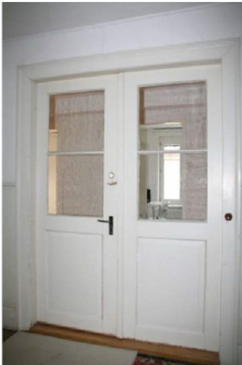
Ilgenstr. 15, 9000 St. Gallen
